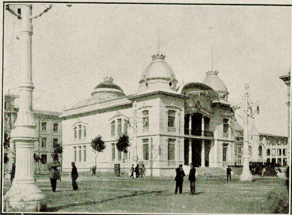
Exterior del Gran Casino
