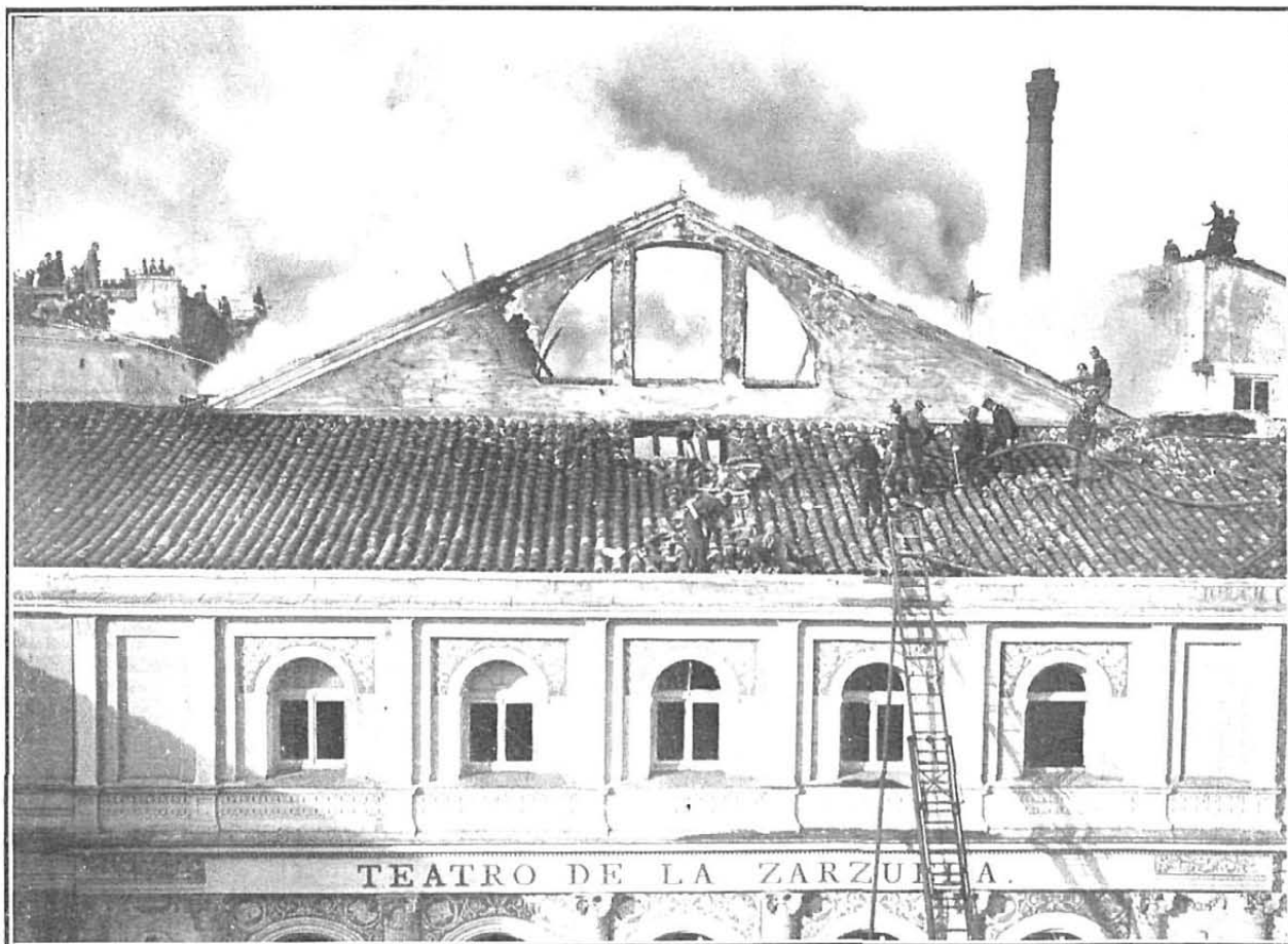
Aspecto imponente que, desde un tejado inmediato, ofrecía el Teatro de la Zarzuela durante el incendio
