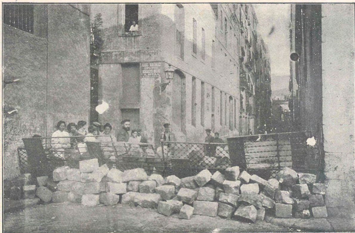
Barricada construida con adoquines y verjas en la calle Nueva de Dulce, junto á la Ronda de San Antonio
