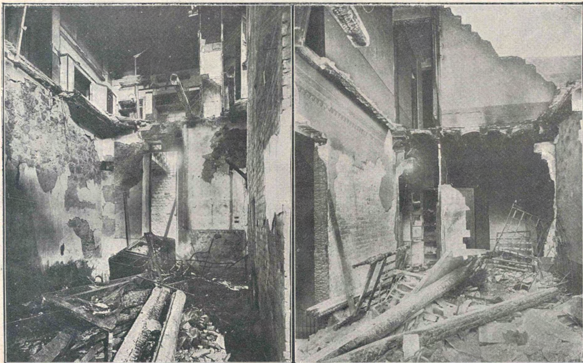
MANRESA.—Cocina y comedores del convento de las monjas Siervas del Sagrado Corazón Aspecto de la sala de labores y celdas del propio convento, después del incendio
