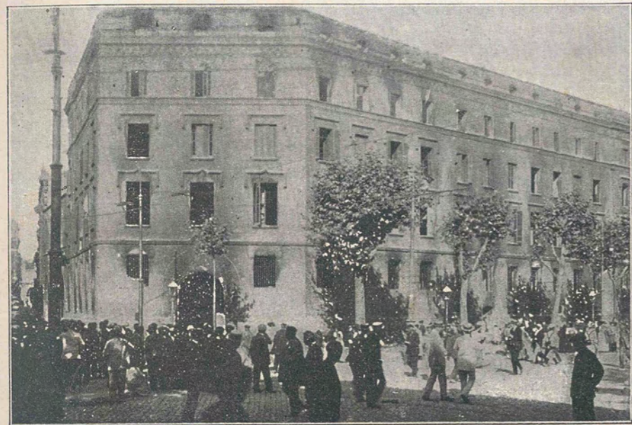
Cuerpo de edificio, chaflán de la calle de San Antonio Abad Foto. MATAMALA
